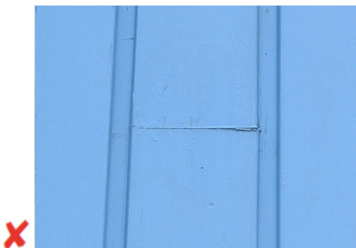
Abbildung 8 - Stumpfstoß falsch montiert (Quelle: Centrum Hout, 2018)
